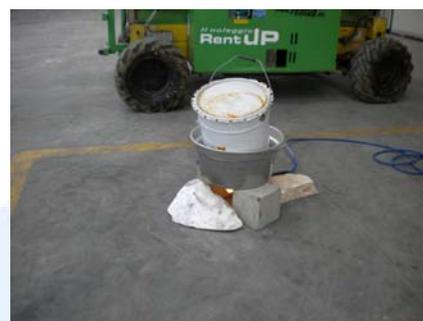
Riscaldamento della resina in immersione in acqua tiepida per facilitarne la reazione di reticolazione.
