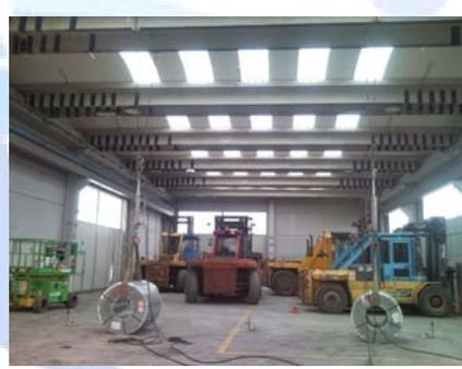
Prova di carico, con martinetti idraulici a tiro, sulle travi rinforzate per verificare l'efficacia del rinforzo attuato.
