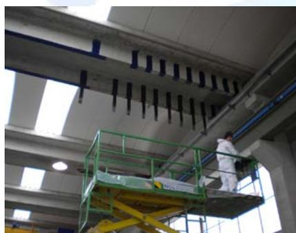
Rinforzo a flessione e a taglio delle travi a pigreco in calcestruzzo armato precompresso, tramite tessuto in fibra di carbonio FIDCARBON UNIDIR 300 HS240.
