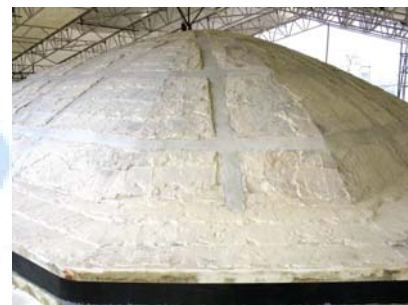
Vista della cupola a rinforzo e cerchiatura ultimati.
