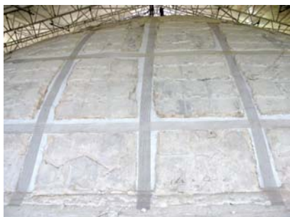
Stesura dei tessuti e successiva impregnazione per mezzo di malte a base di calce pozzolanica.
