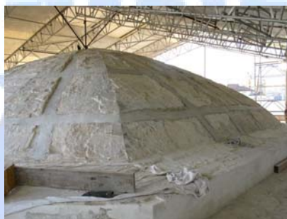
Applicazione di uno strato di malta di allettamento per l'applicazione del rinforzo.
