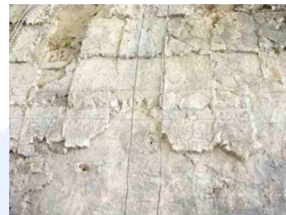
Preparazione dei binari per la posa dei tessuti unidirezionali in fibra di acciaio FIDSTEEL 3X2 12-12-500.
