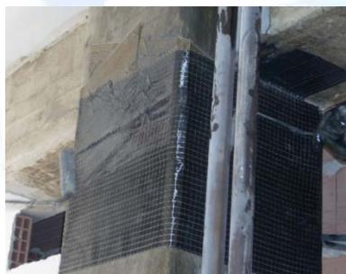
Fasciatura del pilastro tramite tessuto in fibra di carbonio FIDCARBON UNIDIR 320 HS 240.
