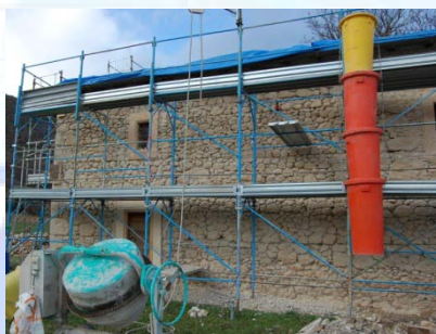
Vista della zona preparata e pronta a esser rinforzata.
