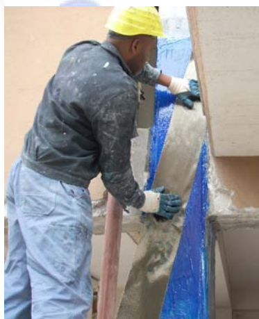
Fasciatura a croce del nodo tramite tessuto in fibra di basalto FIDBASALT UNIDIR 40 C95.
