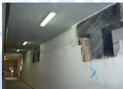
Risultato finale dell'intervento sul nodo.
