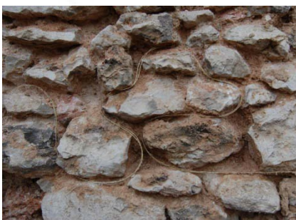
Inserimento del trefolo in fibra di acciaio uhtss FIDSTEEL 3X2-G all'interno del giunto di malta.
