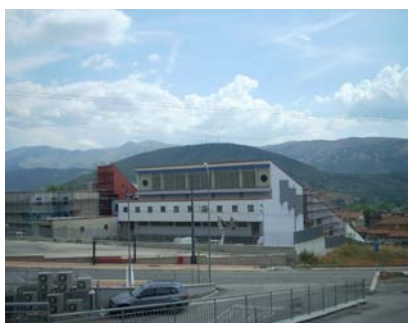
Vista esterna dell'istituto tecnico commerciale Rendina de L'Aquila.
