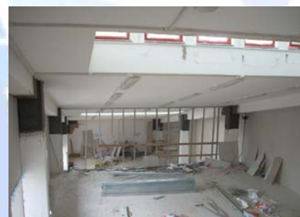
Risultato finale dell'intervento sui nodi della struttura.
