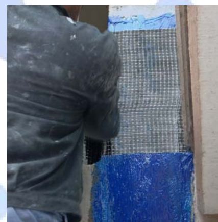
Fasciatura del pilastro tramite tessuto in fibra di carbonio FIDCARBON UNIDIR 300 HS 240.
