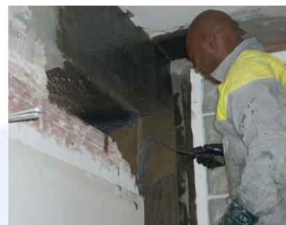
Fasciatura nodo a croce con acciaio UHTSS FIDSTEEL B-3X2 20-12-500.
