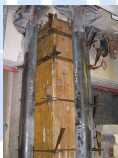
Ripristino della staffatura del pilastro e successivo getto di calcestruzzo.
